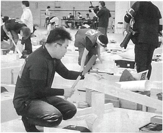
全国から集まる技能集団にも劣らない
