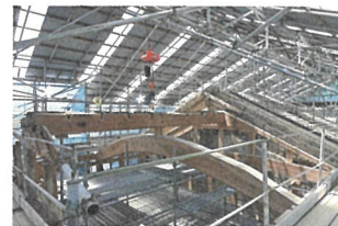
半解体中の土蔵
